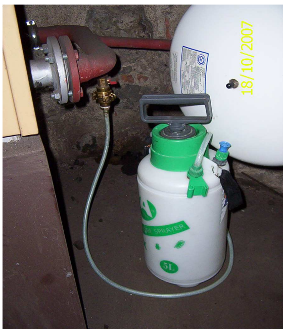
Obrázek č. 18 Plnění inhibitoru koroze do systému
